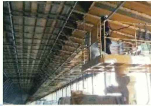
洞門内の梁部材補修状況
